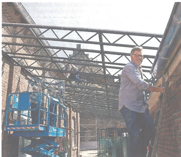
Erfolgskontrolle: Gerardus Aaldering sieht sich die Arbeiten am neuen Dach über den Hof an.
