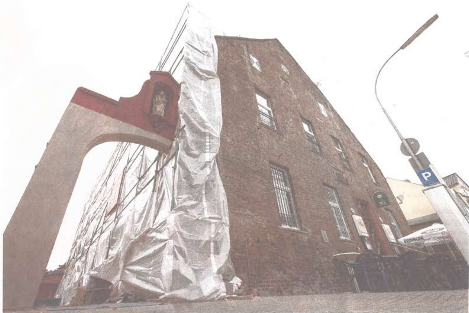
Das mittelalterliche Gemälde in der Wand des Kamper Hofes wird zur Zeit von dem Baugerüst und der Plane (links) verdeckt.
